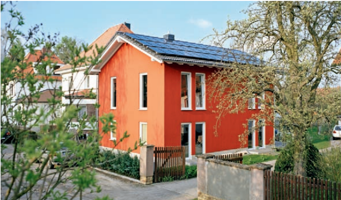
Aufdach-Anlage auf Eigenheim in Leipzig, Deutschland Modul: Q.SMART 75 Leistung: 4 kWp
