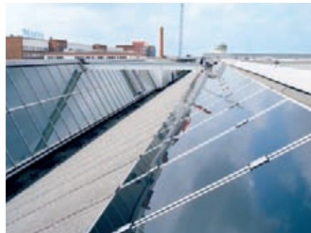
Aufdach-Anlage auf Industrie- gebäude (Scheddach) in Gütersloh, Deutschland Modul: Q.SMART UF 70 Leistung: 502 kWp
