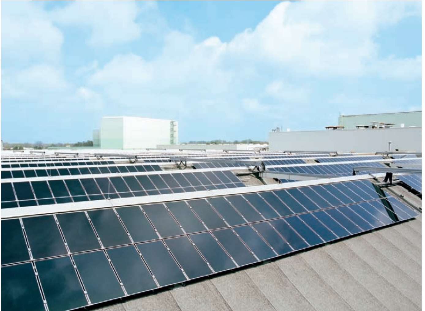
Aufdach-Anlage auf Industrie- gebäude (Scheddach) in Gütersloh, Deutschland Modul: Q.SMART UF 70 Leistung: 502 kWp
