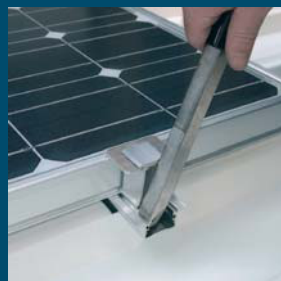
Fixierung der Modulhalter SCG 3.0 mit Biegelehre
