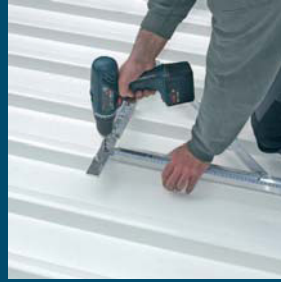
Bohren mit Bohr-Lehre
