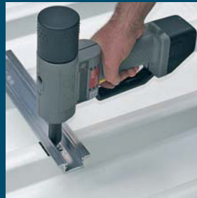
Vernietung des Trägerprofils mit Dichtung auf Hochsicke
